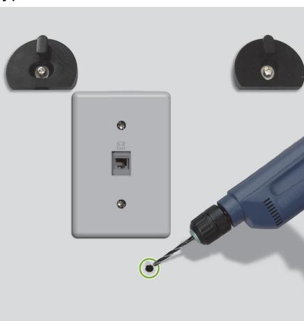
Bohren Sie das angekörnte Loch. Setzen Sie abhängig von der Beschaffenheit der Wand einen passenden Dübel ein.
