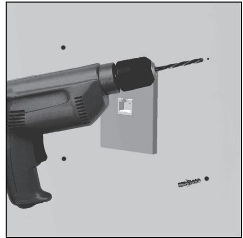
Bohren Sie die Löcher. Setzen Sie abhängig von der Beschaffenheit der Wand passende Dübel ein.
